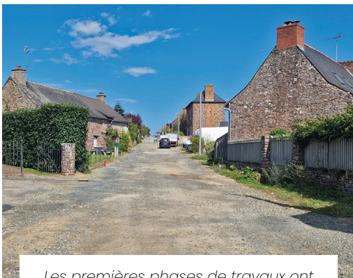
Les premières phases de travaux ont permis de remplacer les réseaux d'eaux pluviales et d'eaux usées. Les lignes électriques et Télécom ont été enfouies.
